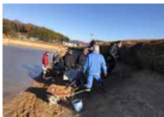
かいぼりで堤体の点検を行いました
